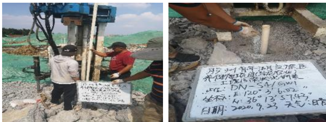
图 5-5 地下水井建井照片
