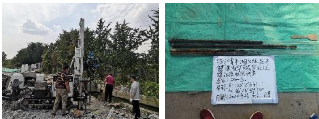
图 5-3 钻机钻进和取出的土壤样品
